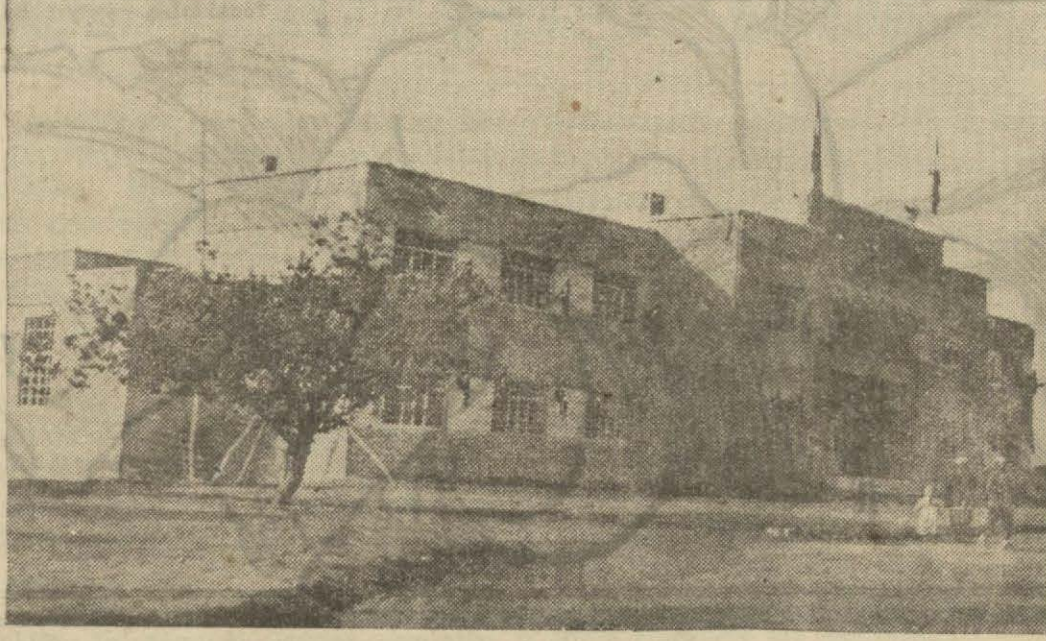
Elâziz Halkevi binası
